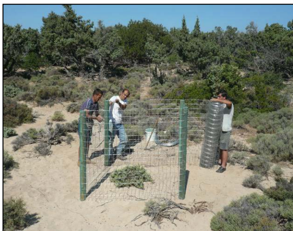
Εικόνα 42: Εργασίες εγκατάστασης περιφράξεων στη θέση Κεδρόδασος
