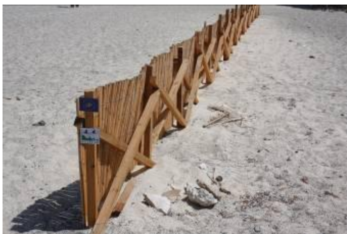
Ανασχετικό πέτασμα με ξύλινο σκελετό και καλάμια
