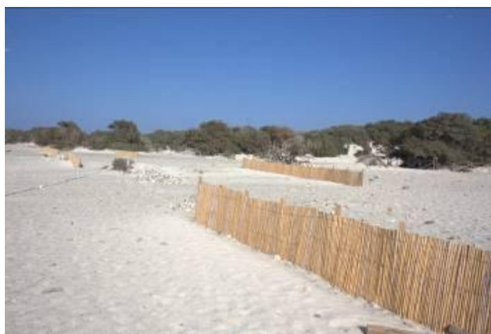
Ανασχετικά πετάσματα στη νήσο Χρυσή
