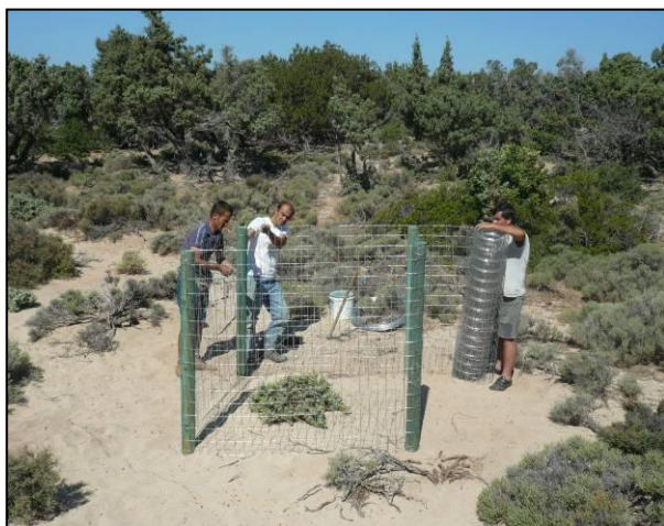
Εικόνα 45. Εργασίες εγκατάστασης περιφράξεων στην περιοχή Κεδρόδασος.
